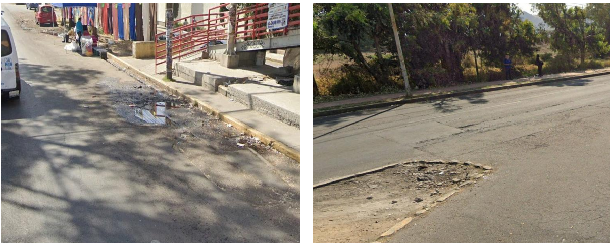
Ilustración 6 Estado actual del camino
